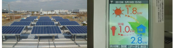
4kWクラス系統連系型 京都府京田辺市
