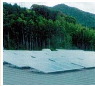
架台で角度を付けることで、「黄砂」「埃塵」を雨で流します。
